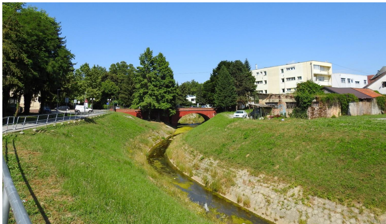
Sl. 36. Kanalizirano korito Kutinice u centru grada
