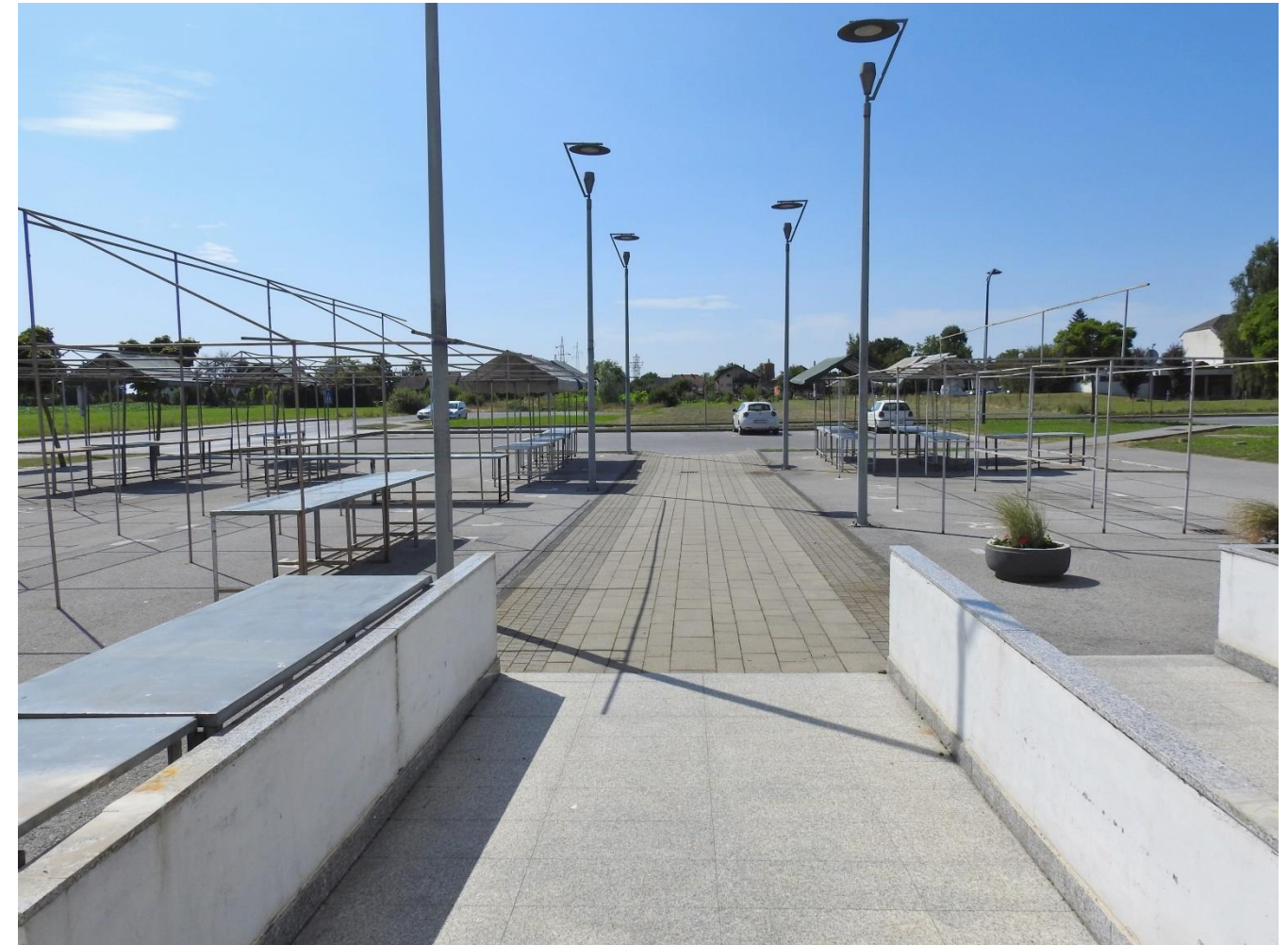
Sl. 92. Nedostatak zelenila u prostoru nove tržnice
